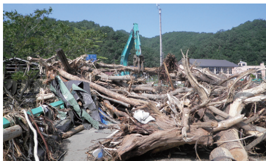
被災後の状況（岩泉町安家地区 仙台市消防局提供）
