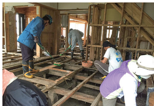
床下の泥だし (岩泉町災害ボランティアセンター提供)
